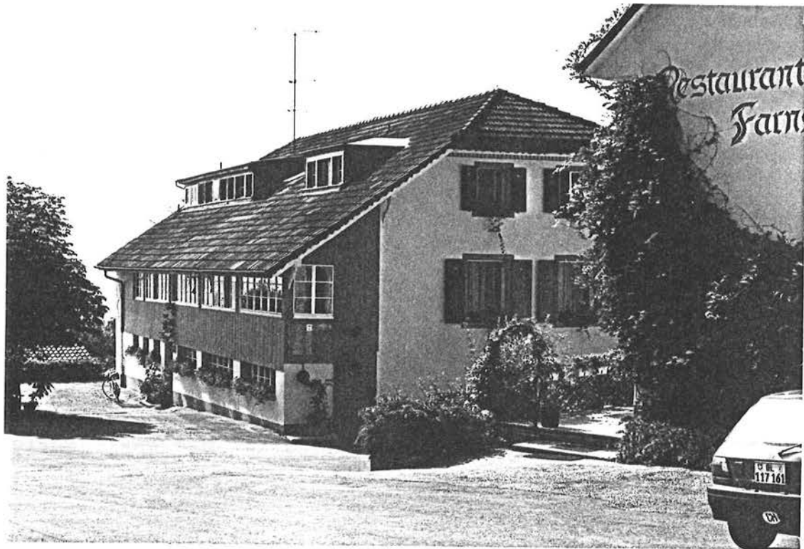
Wohnhaus, Ansicht von Nordosten
