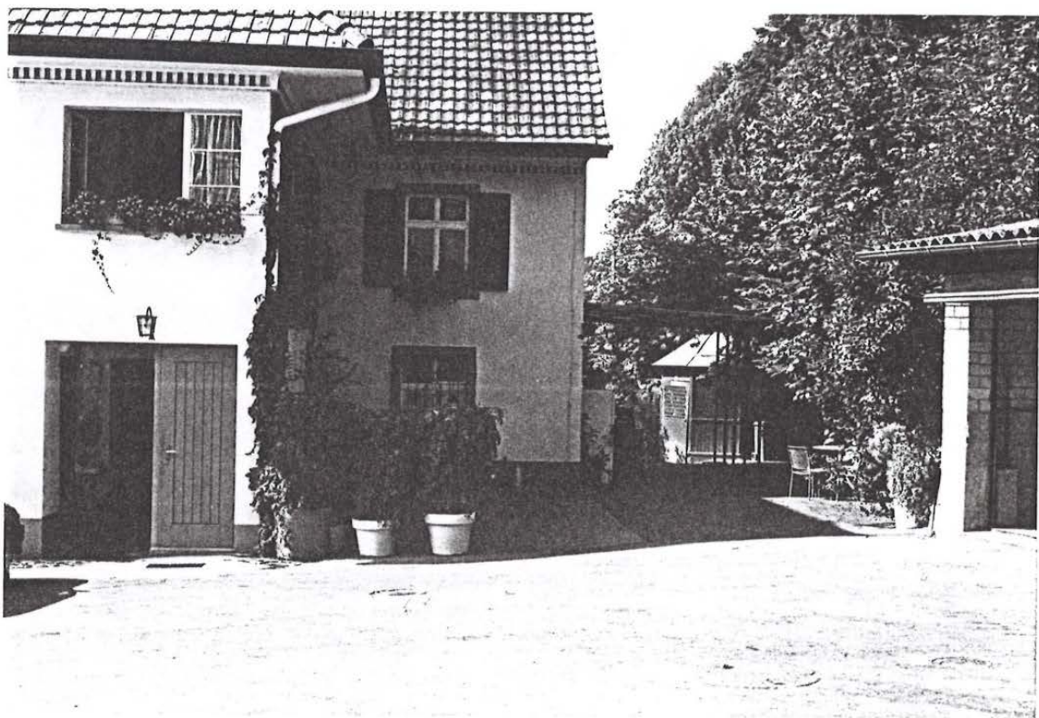
Gasthof im Bereich der noch nicht ausgeführten Küchen- erweiterung, Ansicht von Norden
