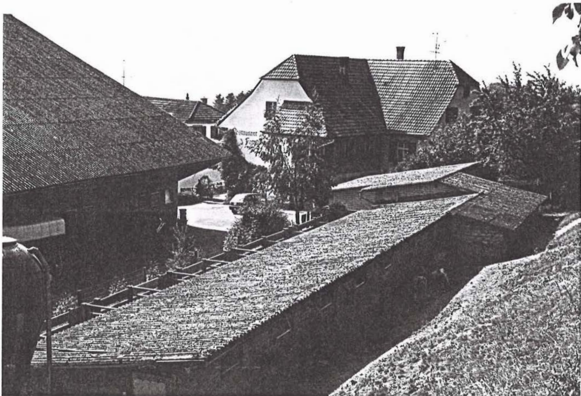
Gasthof, Ansicht von Nordwesten
