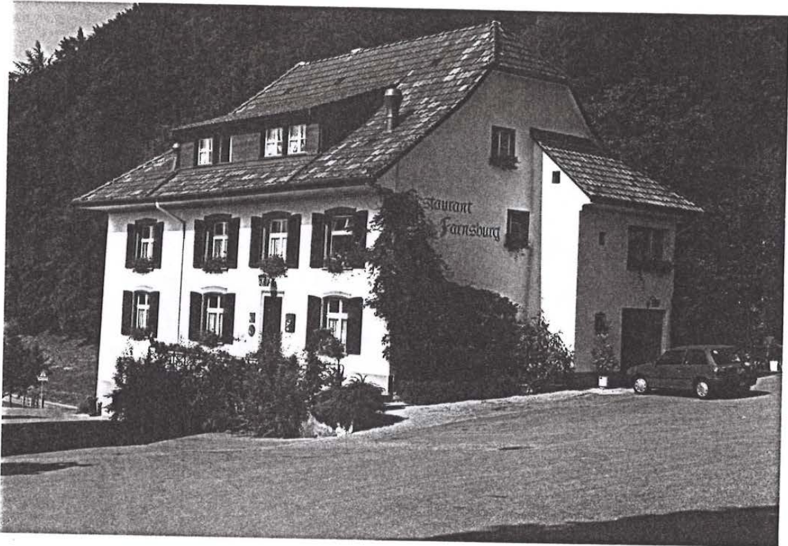
Gasthof, Ansicht von Nordosten
