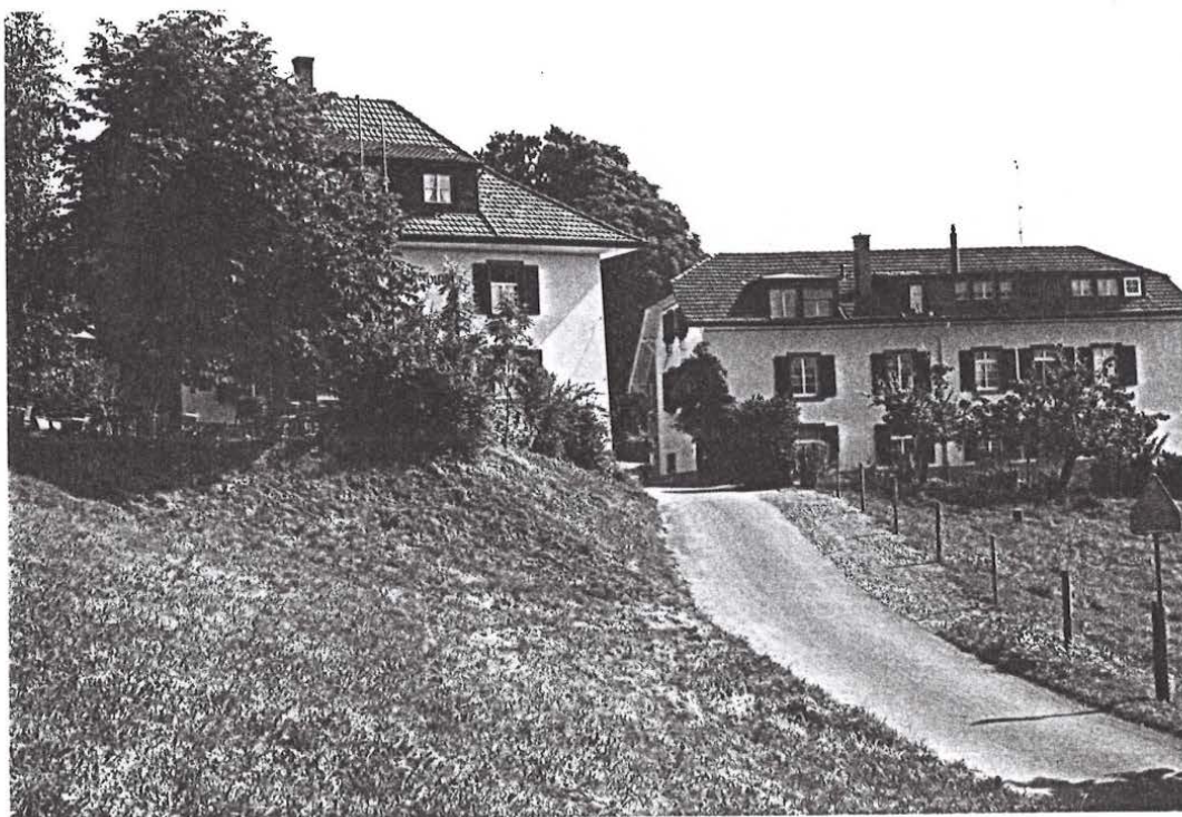
Gasthof und Wohnhaus, Ansicht von Süden
