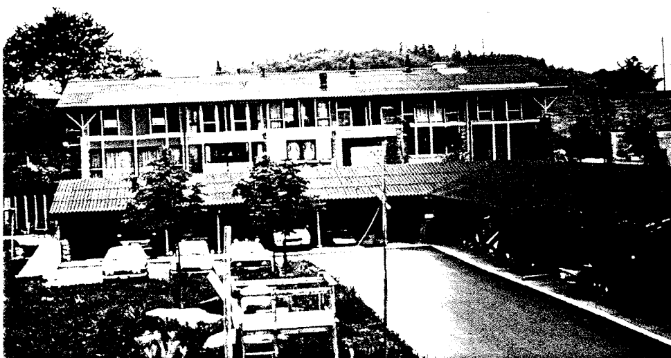
Offene Autounterstände als Sammelgaragen am Rande der Siedlung.
