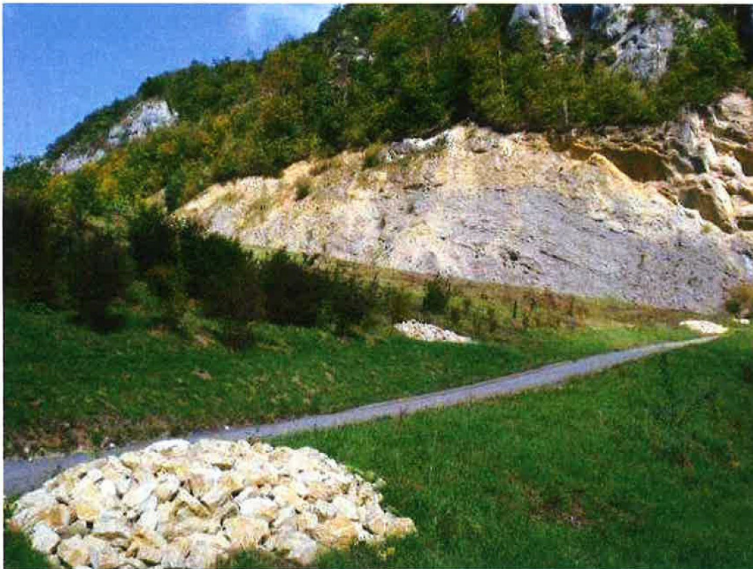
Abbildung 17: Im linken Bildrand sind die bereits gepflanzten Gebüschgruppen im unteren Bereich der Deponieoberfläche zu sehen. Diesen Gebüschgruppen fehlt noch der ökologisch wichtige Krautsaum.
