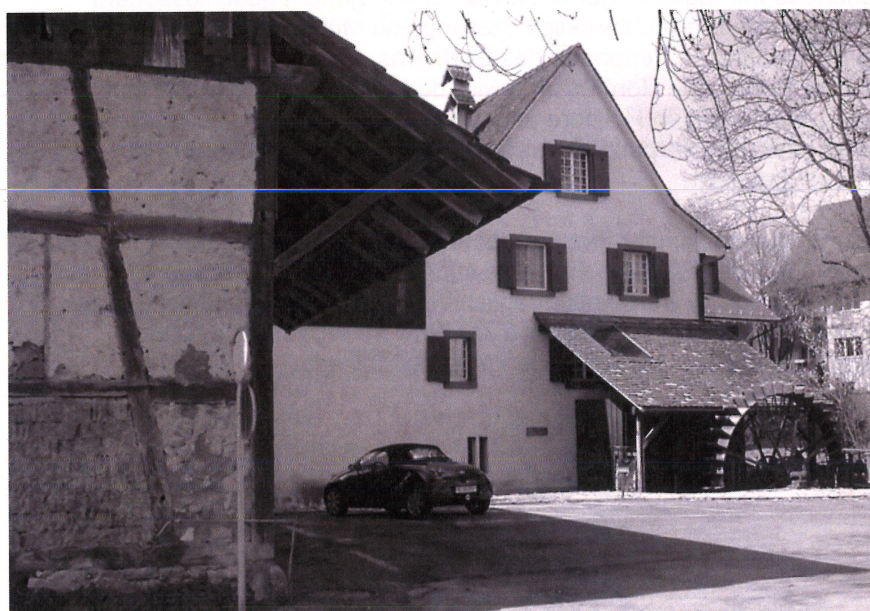
Ansicht Gipsmühle und Scheune
